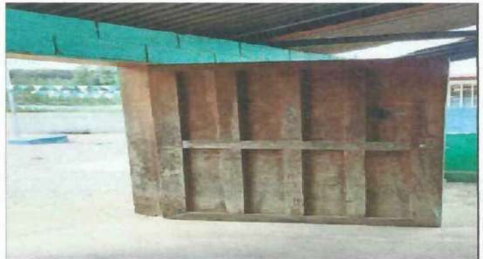
Foto 4: sustitución de 2 puertas de metal.
