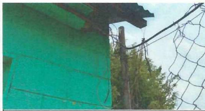
Foto 5: mantenimiento al sisema electrico.
