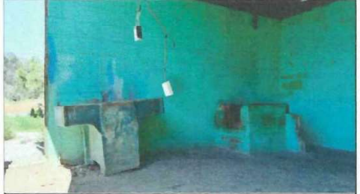
Foto 2: instalación de piso cerámico, Sustitución de pila de cemento de 2 labaderos, elaboracion de estufa rural.
