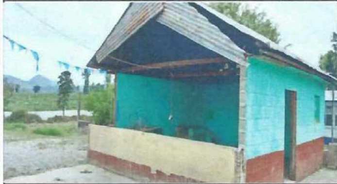
Foto1: Mejoramiento y seguimiento de muro para cocina, estructura de techo y cubierta de lamina de techo para cocina.
