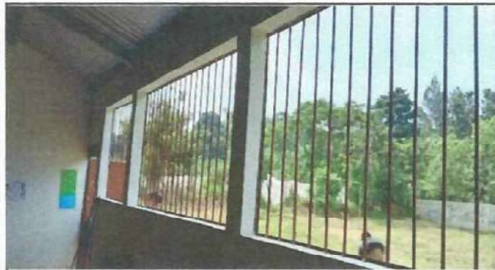
Foto 3: Elaboracion de 9 ventanas de estructura de metal.
